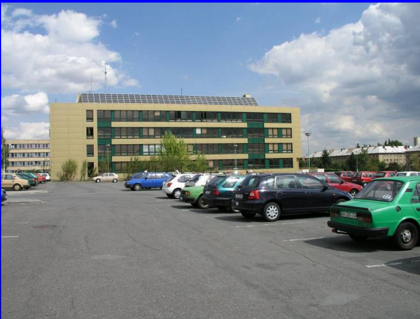
Obr.4. Solární střecha s FV systémem LfVSS(20kWp, od 2003).
