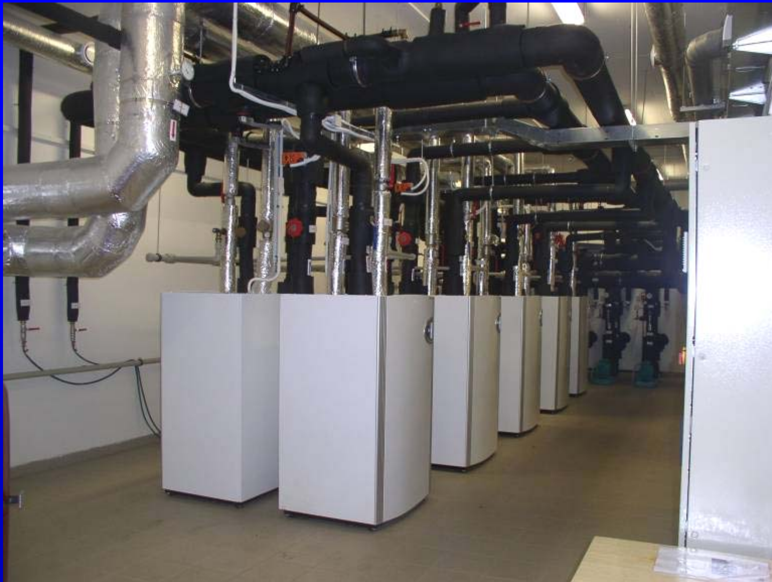
Obr.6. Strojovna tepelných čerpadel v budově Nové Auly.
