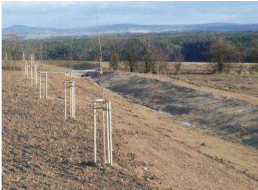
Zasakovací průleh s propustkem
