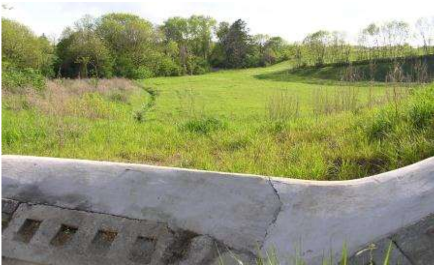
Hrázka suché nádrže na území nivy
