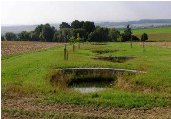
Zasakovací jámy – drenážní vody
