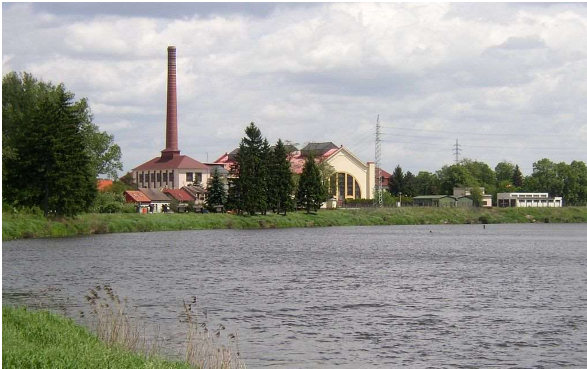
Vodárna Káraný: v provozu od r. 1914, od roku 1968 – umělá infiltrace Do Prahy – 1,5 m 3 /s pitné vody, 3 zdroje vody: břehová infiltrace, umělá infiltrace, artéská voda
