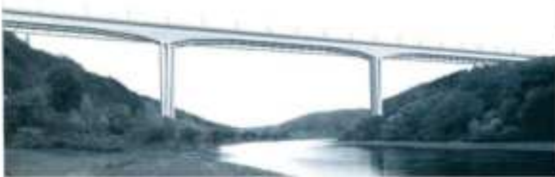
Obr. 8a Letmo betónovaný betonový předpjatý most (provoz pěstích v dolní úrovni)
